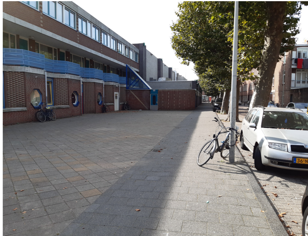
huidige situatie versteende ruimte
