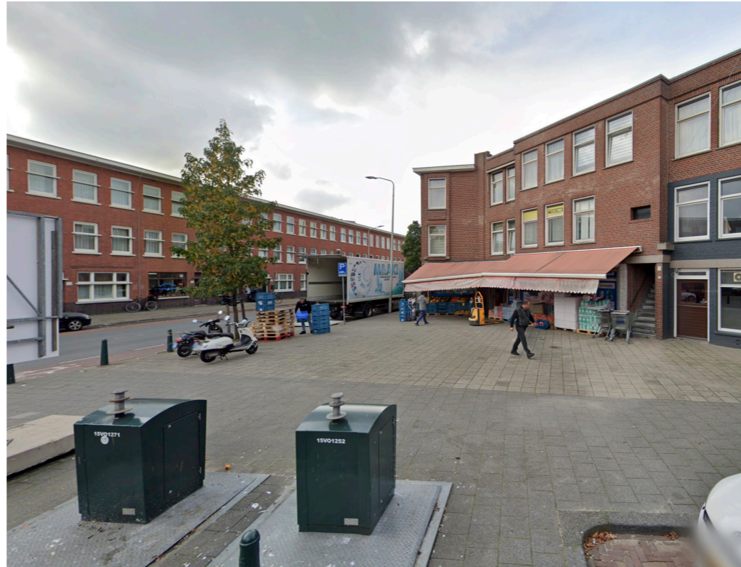
aanzicht van de overruimte met supermarkt
