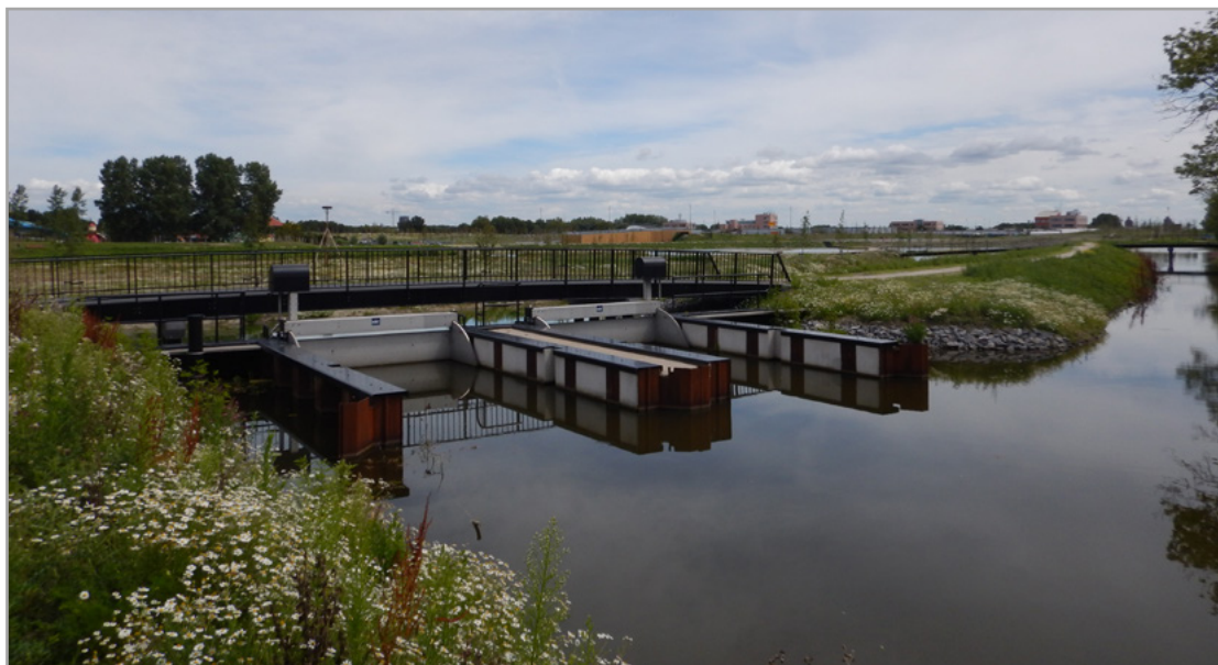
Figuur 3.5 Inlaatwerk calamiteitenberging Molenvlietpark
