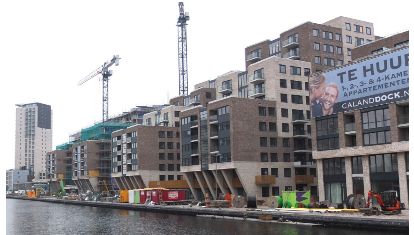
bebouwing aan de Calandkade: werk in uitvoering
