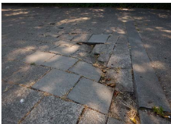
Scheurvorming in bestrating als gevolg van droogte in de zomer van 2018.
