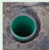
Infiltratieputten en -riool
