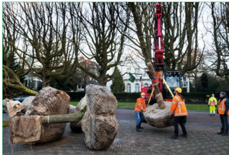
Grotere bomen aanplanten op plein 1813. Het gaas en de gloeidraad zijn goed zichtbaar. Foto: Jurriaan Brobbel.
